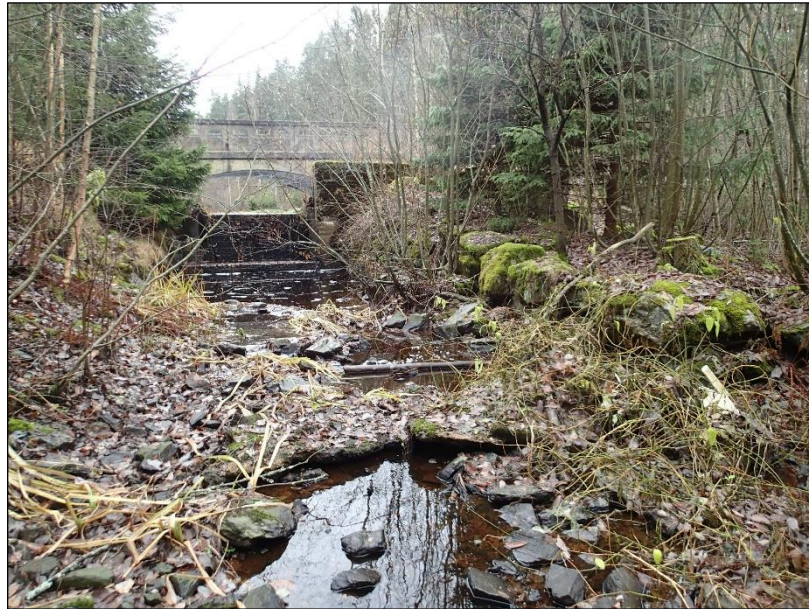
Kivin pengerrettyä uomaa Björkenheimin sillan pohjoispuolella. Kuvan taustalla näkyy uomassa oleva betonipato sekä Björkenheimin silta. Etelään.
